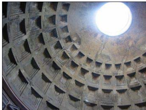
Innenansicht der Kuppel
